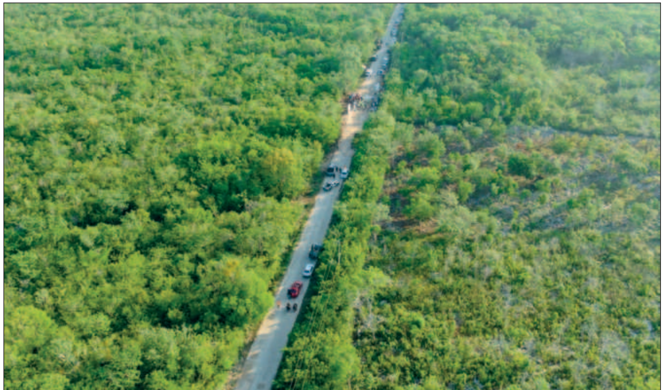
▲ La construcción del Tren Maya en la zona lleva un avance de 80 por ciento. Foto ayuntamiento de Tulum
