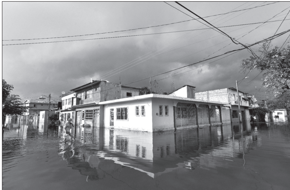
▲ De no cerrarse la compuerta el Macaio, estaríamos hablando de más gente afectada, indicó el Presidente. En la imagen, aspecto de los daños en Villahermosa. Foto Efe
