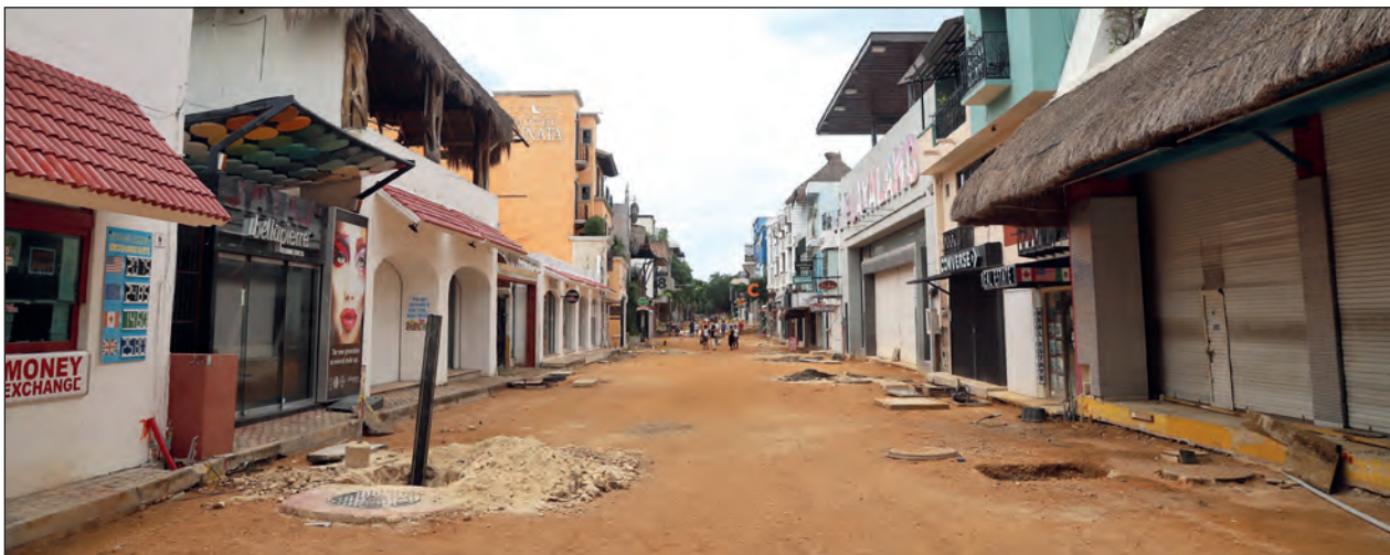
▲ Empresarios de la Riviera Maya solicitaron a la autoridad municipal de Solidaridad mayores avances en las obras de remodelación de la Quinta Avenida para evitar cierres y despidos de personal. Foto Juan Manuel Valdivia
