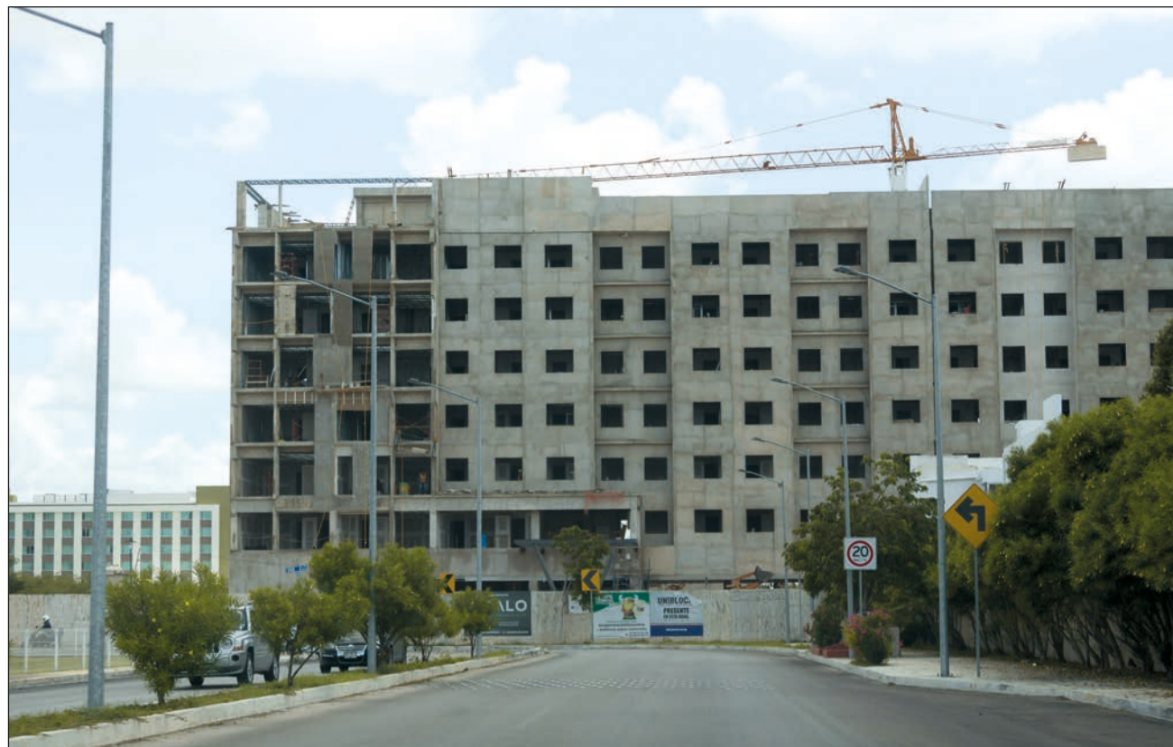
▲ Una construcción vertical es inaceptable si carece de estudios de impacto de vientos. Foto Enrique Osorno
