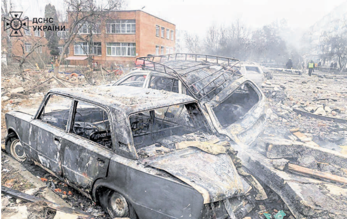
▲ Daños causados por un ataque ruso en Ucrania, 2025. Foto: Servicio de Emergencias de Ucrania vía AP.
