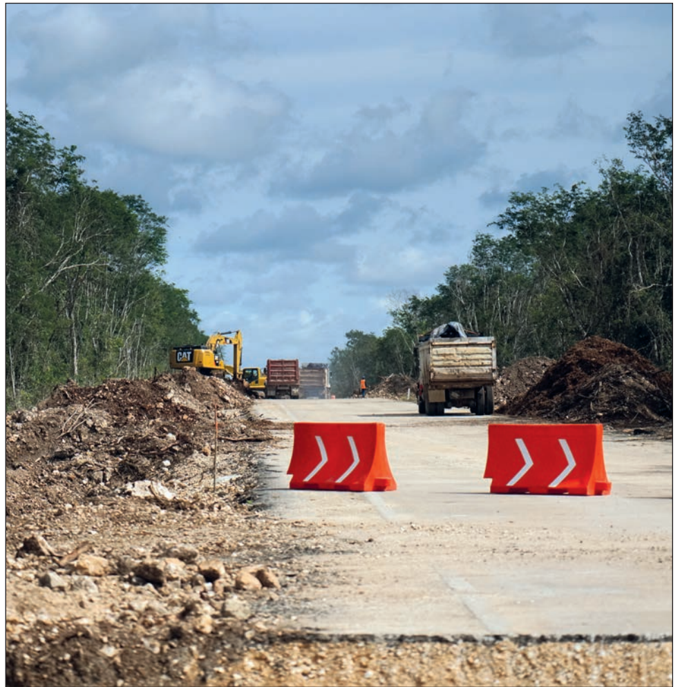
▲ La autopista Mérida-Cancún es zona de trabajos del tramo 4 del Tren Maya. Foto Raúl Angulo Hernández
