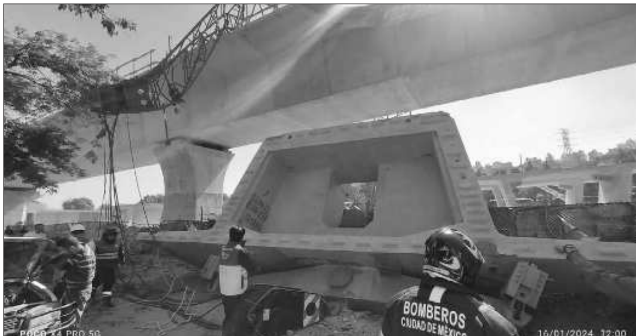
▲ El incidente ocurrió en el apoyo 18 en el frente de obra Minas de Arena cuando la dovela era transportada por una grúa sobre el Viaducto. Las autoridades dieron a conocer que no se reportaron personas heridas. Foto @Bomberos_CDMX
