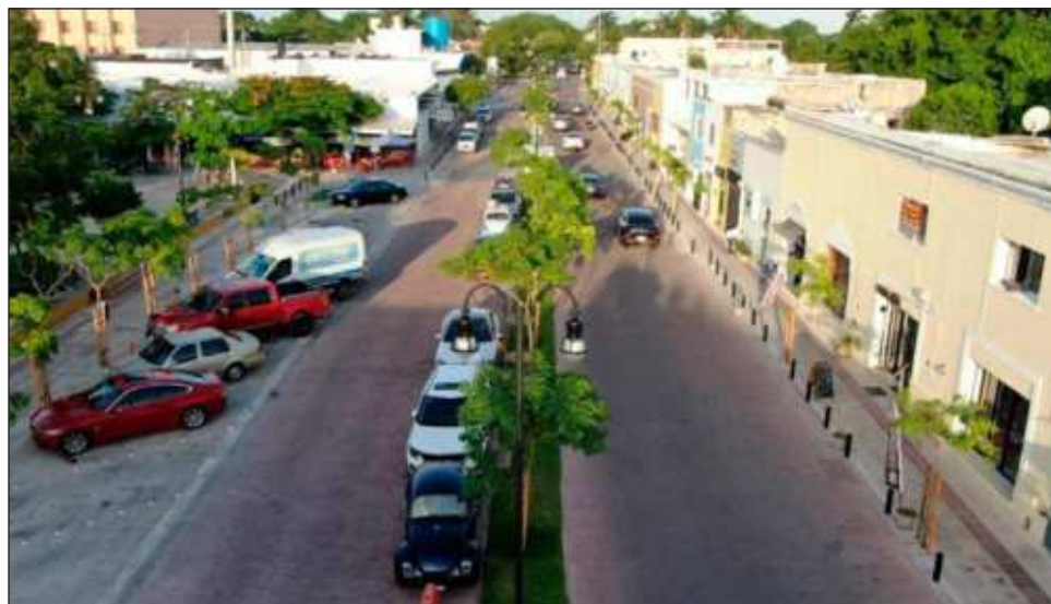
▲ El gobernador Mauricio Vila agradeció el apoyo y la paciencia de los locatarios y vecinos, quienes han respaldado las labores de construcción. Foto gobierno de Yucatán
