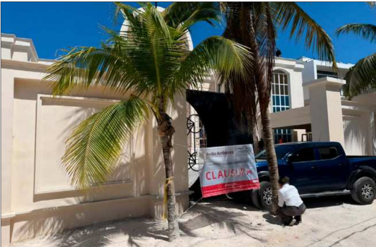
▲ La procuradora Mariana Boy Tamborrell advirtió que todo aquel que construya sin los permisos requeridos tendrá que regresar el terreno a su estado original, lo que podría implicar la demolición de obras ya edificadas. Foto Profepa
