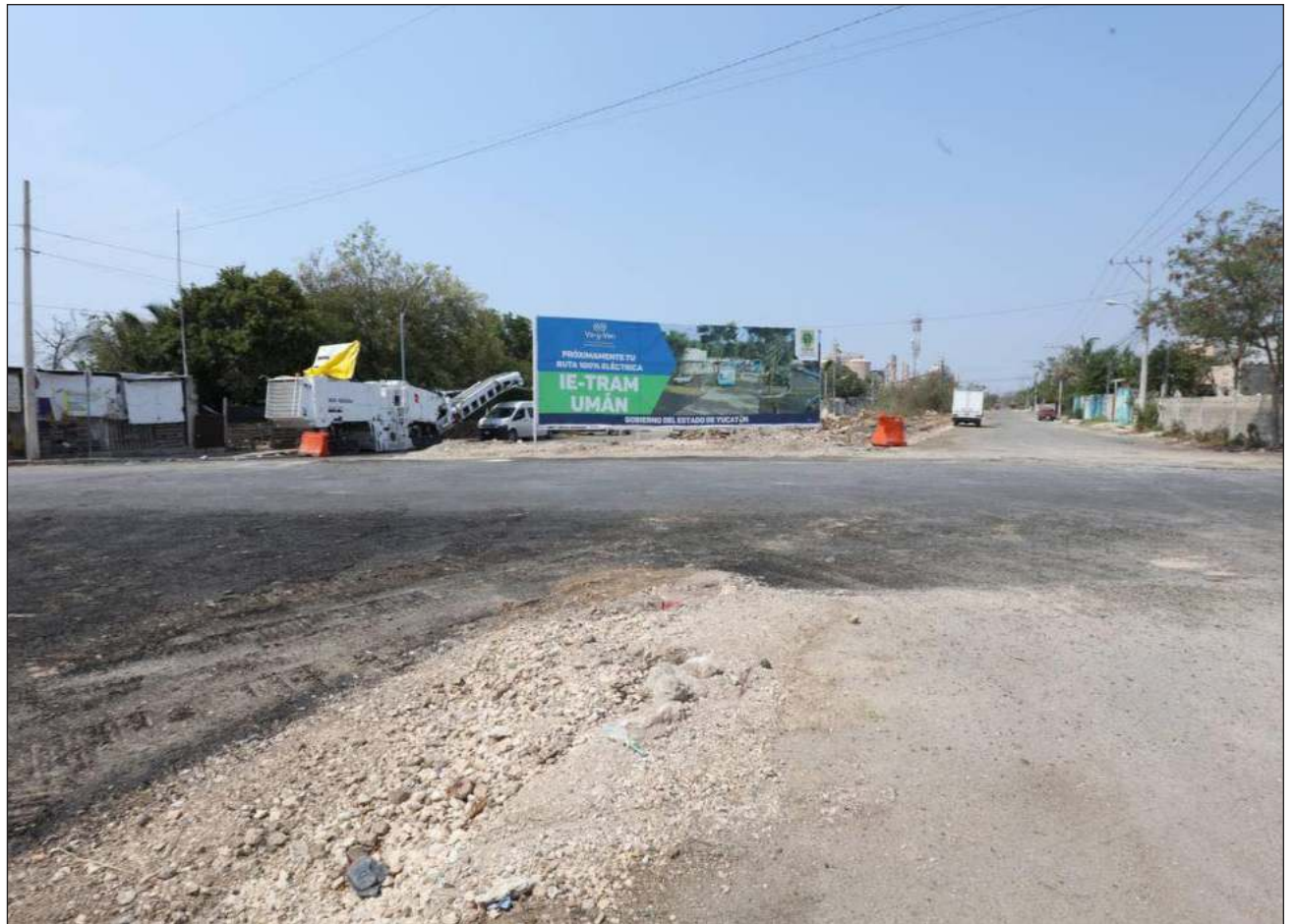
▲ El Instituto de Infraestructura Carretera de Yucatán informó que ya se comenzó esta obra que correrá desde la calle 128 de la colonia Ciudad Industrial hacia el Anillo Periférico, paralela a las antiguas vías del ferrocarril. Foto gobierno de Yucatán
