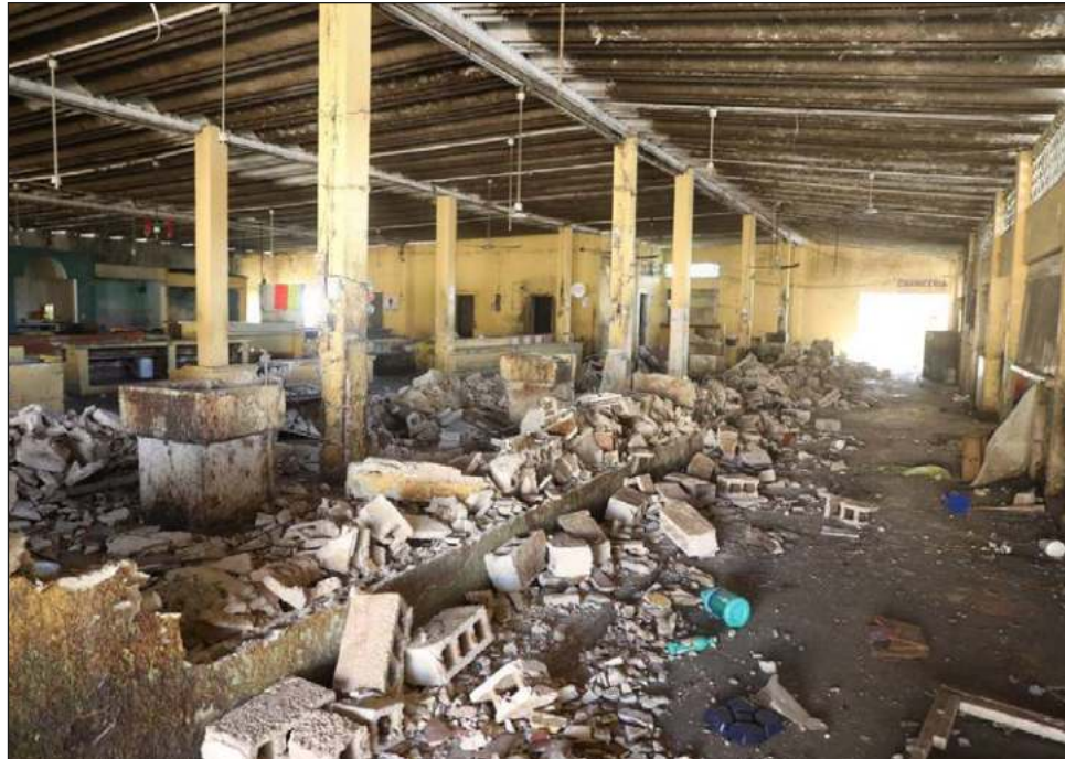
▲ Con la demolición del antiguo centro de abasto se da paso a la edificación del nuevo edificio que tendrá una inversión de 30 millones de pesos. Foto gobierno de Yucatán
