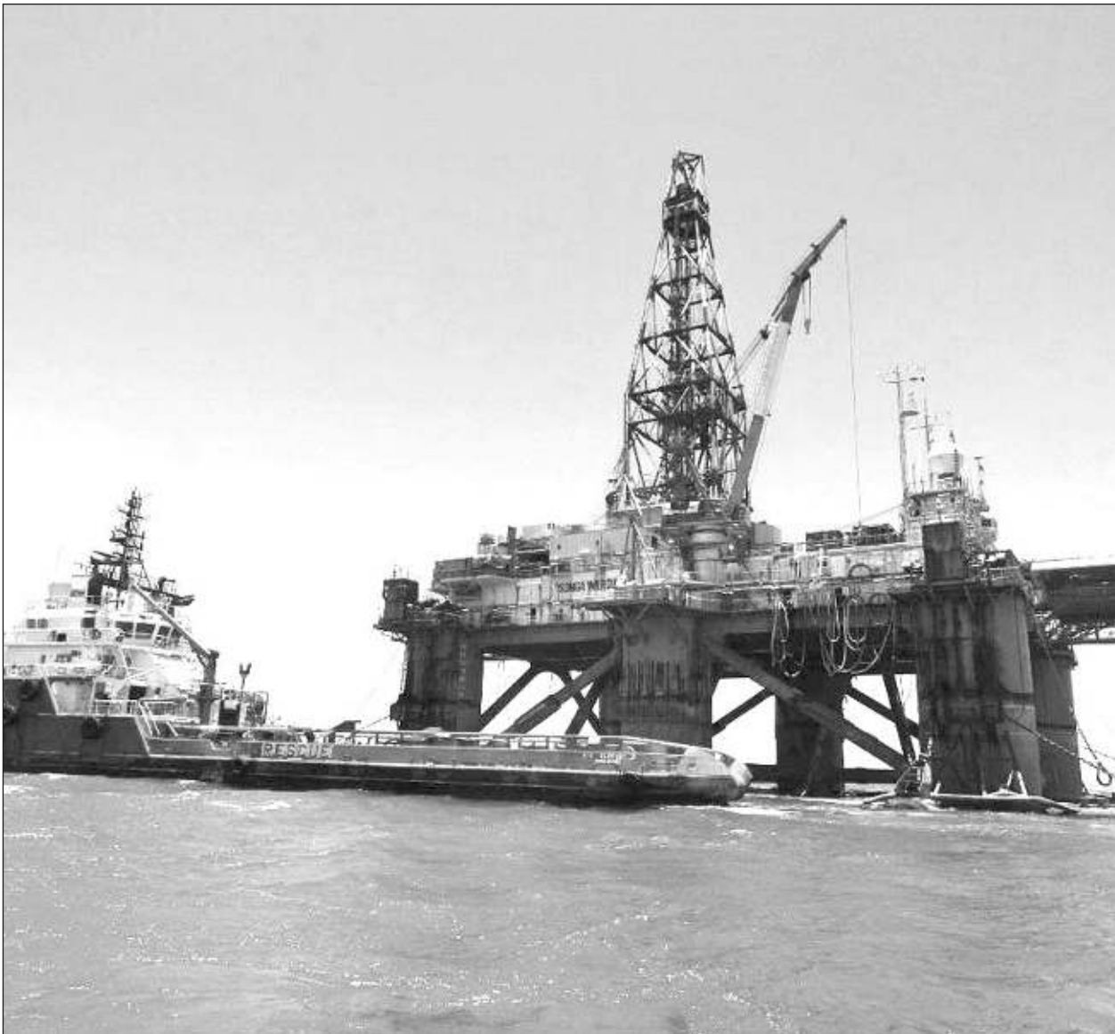
▲ El líder de la Unión de Pescadores Libres de Isla Aguada, Víctor Serna, señaló que durante años Pemex ha tratado de ocultar los derrames y fugas de gas y aceite que se registran en sus instalaciones. Foto LJM
