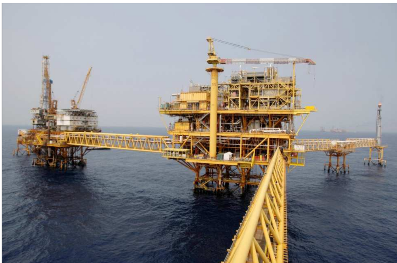
▲ De acuerdo con un comunicado difundido por Petróleos Mexicanos, se continúa con la reparación del ducto en campo Ek-Balam, luego de concluir la elaboración de envoltente e iniciar su instalación. Foto Reuters / Archivo
