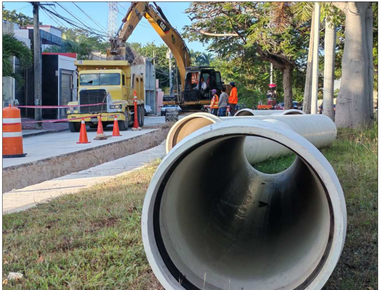
▲ Bernhard Rehn detalló que el proyecto incluye la eliminación de desniveles, trabajos de drenaje, mejoramiento de la infraestructura vial, alumbrado público y la incorporación de árboles, además de otras adecuaciones. Foto Lucio Blanco
