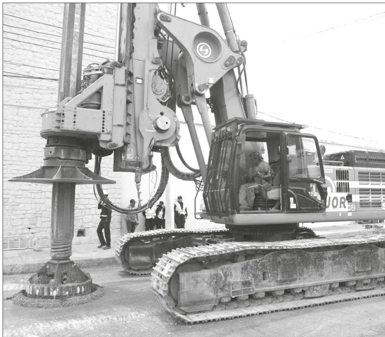
▲ Los trabajos de construcción empezaron con la perforación para el establecimiento de las cuatro columnas que soportarán la superestructura del libramiento, obra que beneficiará a más de 66 mil personas. Foto gobierno de Yucatán
