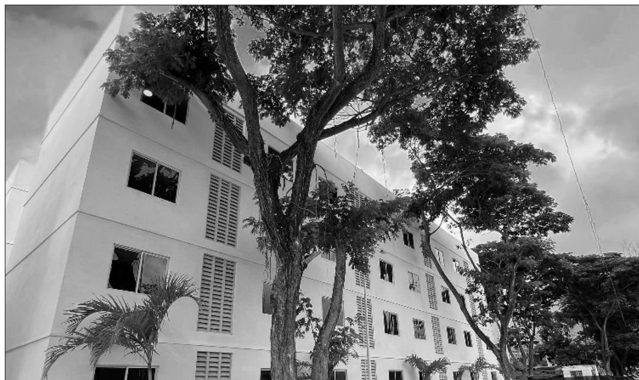
▲ En el fraccionamiento de Comalcalco se construyen 192 viviendas y ayer se entregaron a 64 familias. Foto FB Edna Vega Rangel
