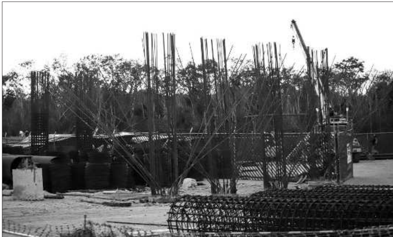
▲ El tramo 5 Sur del Tren Maya abarca 66.7 kilómetros; se dividió en tres subtramos que están a cargo de diferentes constructoras contratadas por la Secretaría de la Defensa Nacional: Mota-Engil México, Grupo Indi e ICA. Foto Juan Manuel Valdivia
