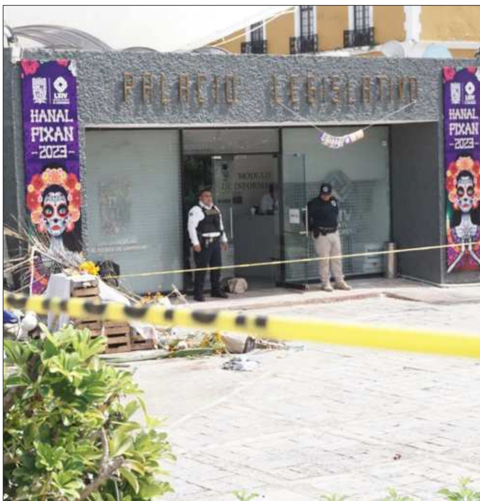
▲ Los detenidos fueron sentenciados por daños en propiedad ajena en pandillerismo. Foto Fernando Eloy
