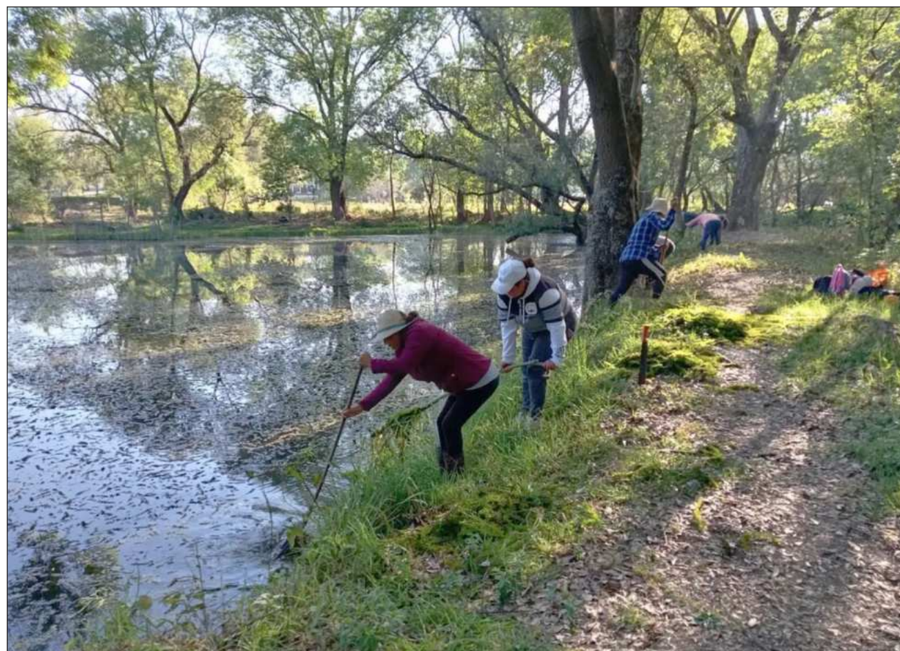
▲ Se conformaron 4 mil 500 metros lineales de acordonamiento de material vegetal muerto y 180 metros lineales de franja de protección con cinco mil piezas de geocostal para el humedal de Jarácuaro. Foto La Jornada
