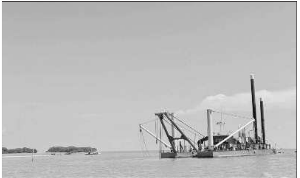
▲ El desazolve se desarrolla en tres etapas que van desde la desembocadura a la Laguna de Términos, hasta la capital del municipio. Foto Facebook Gobierno Municipal Palizada 2021-2024
