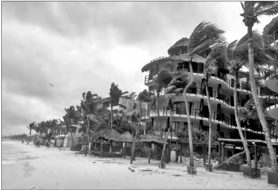
▲ La mayoría de los centros de hospedaje de la Riviera Maya sufrieron daños menores por los fuertes vientos del huracán. Foto Rosario Ruiz
