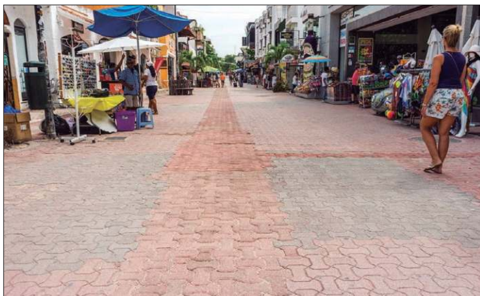
▲ Las maniobras consistirán en el remplazo de 131 metros de tubería de PVC de 8 pulgadas, las cuales se estarán ejecutando durante el periodo de abril a julio. Foto Aguakan
