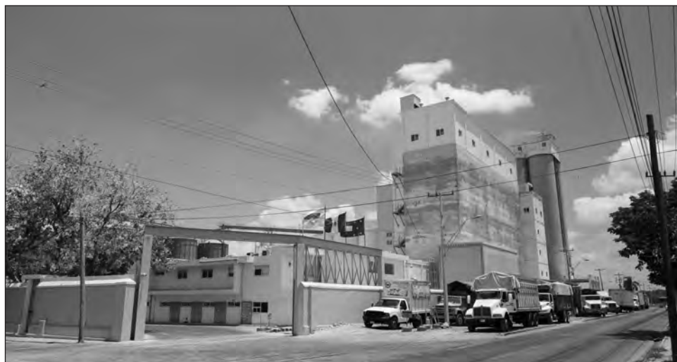
▲ Alrededor de las instalaciones de Harinas del Sureste también se instalan camiones que perjudican la movilidad. Foto Enrique Osorno
