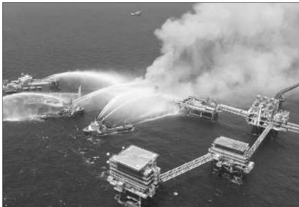
▲ En las plataformas marinas se extraen hidrocarburos, los cuales vienen acompañados de gas amargo, el cual es muy peligroso, "aunque todos los trabajos en estas instalaciones son de alto riesgo, la falta de mantenimiento, aumenta el peligro", señaló el presidente del Clúster de Energía. Foto Pemex
