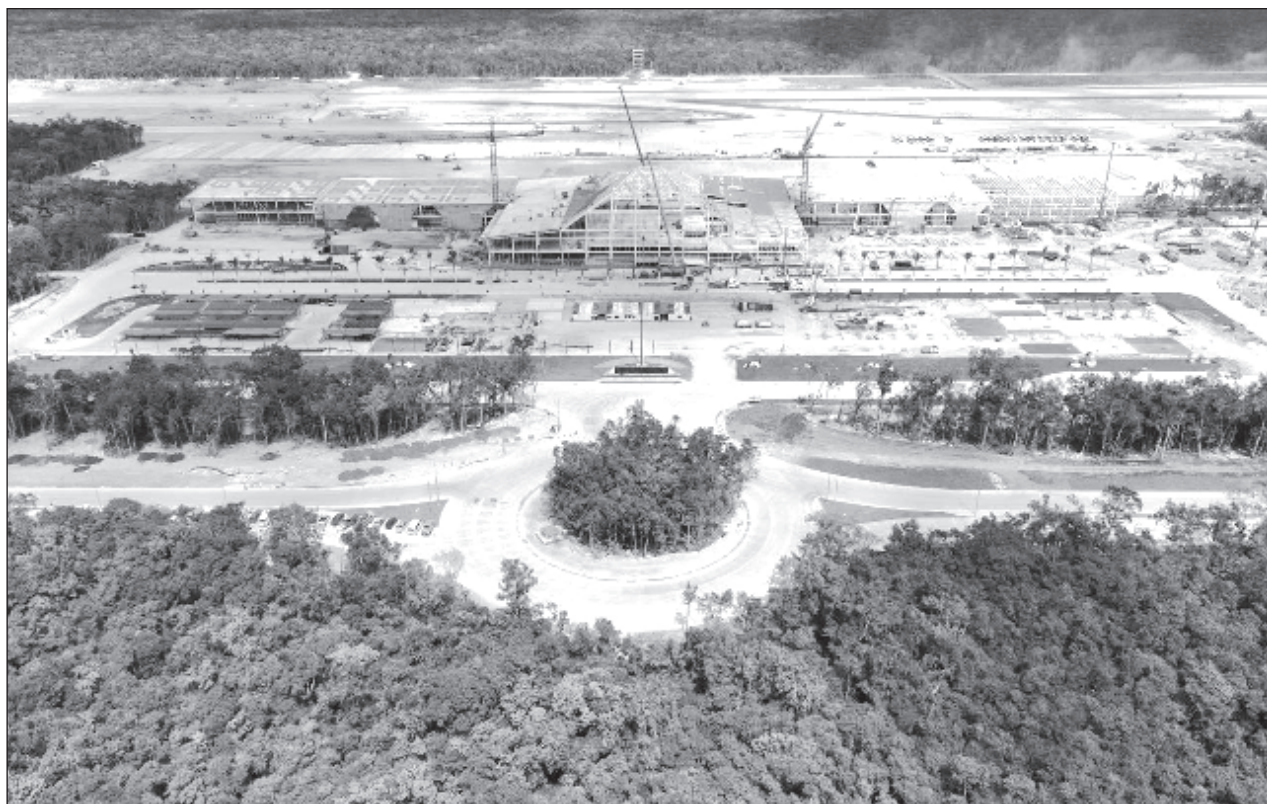
▲ El aeropuerto abre la posibilidad de suministrar carga del centro del estado hacia el sur, hacia el norte y cubrir de forma más certera la parte de Belice y Centroamérica en general. Foto Facebook Aeropuerto Internacional de Tulum
