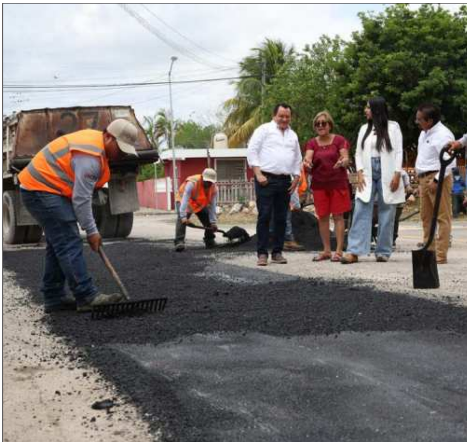
▲ Joaquín Díaz Mena enfatizó su compromiso de reparar toda la colonia hasta alcanzar cero baches en esta zona ubicada al sur de la ciudad. Foto Facebook Huacho Díaz Mena
