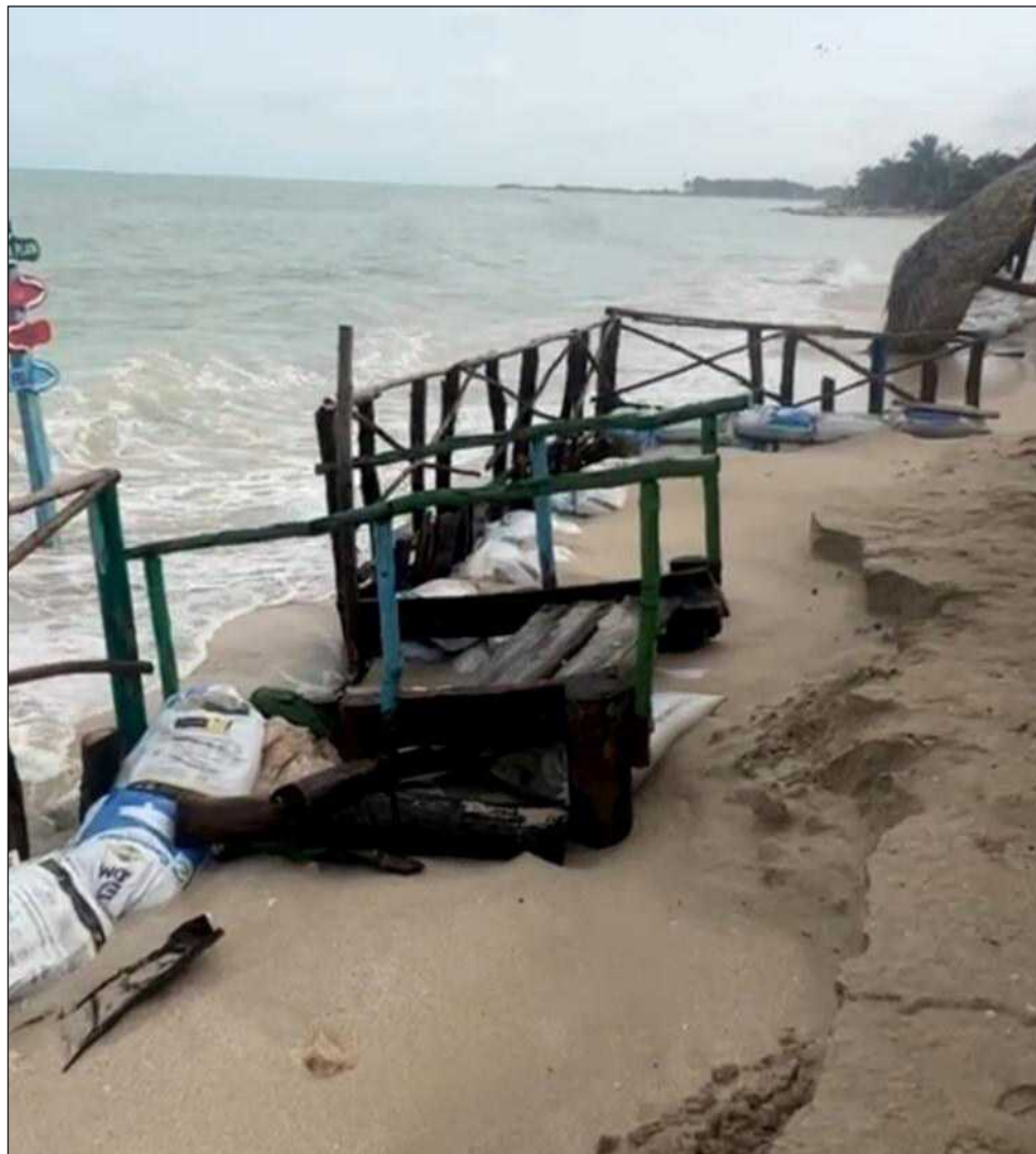
▲ En la zona de la playa se puede notar que el mar ha erosionado la arena, dejando una altura de hasta 80 centímetros aproximadamente y amenazando con derribar una de las palapas de más de seis metros, instalada en el área para esparcimiento familiar. Foto LJM
