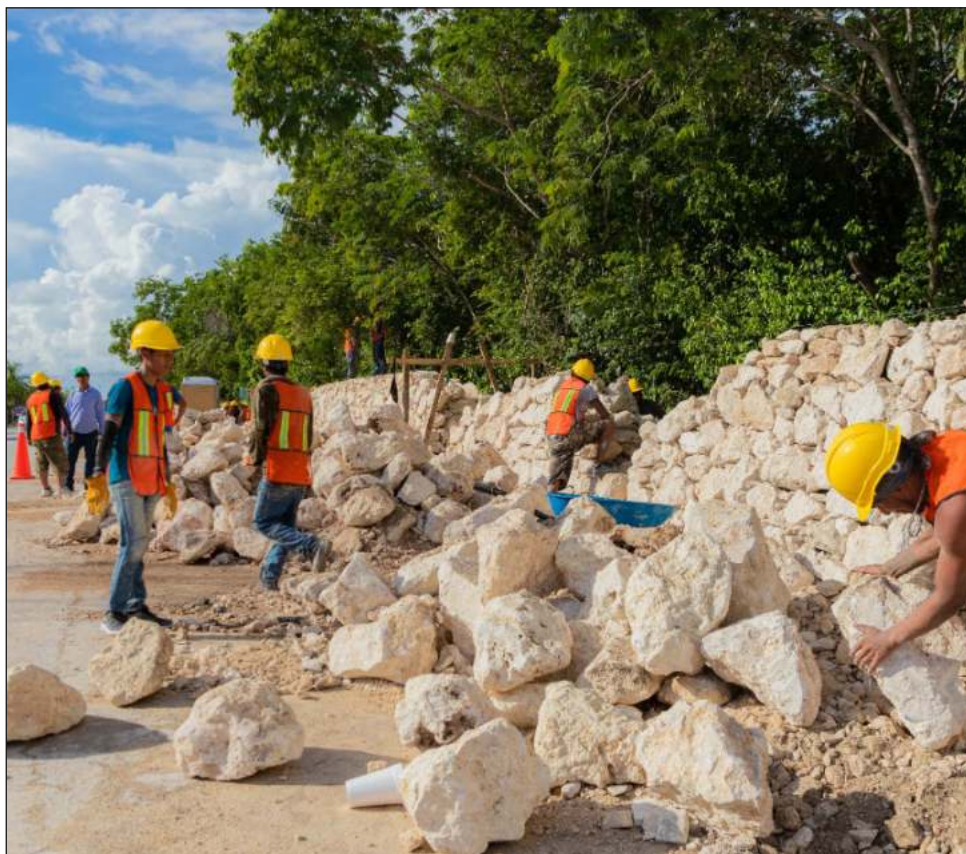
▲ Trabajadores de la Sedatu ya comenzaron con el levantamiento de una barda perimetral de 21 kilómetros que irá acompañada de una ciclovía con sendero peatonal. Fotos Sedatu
