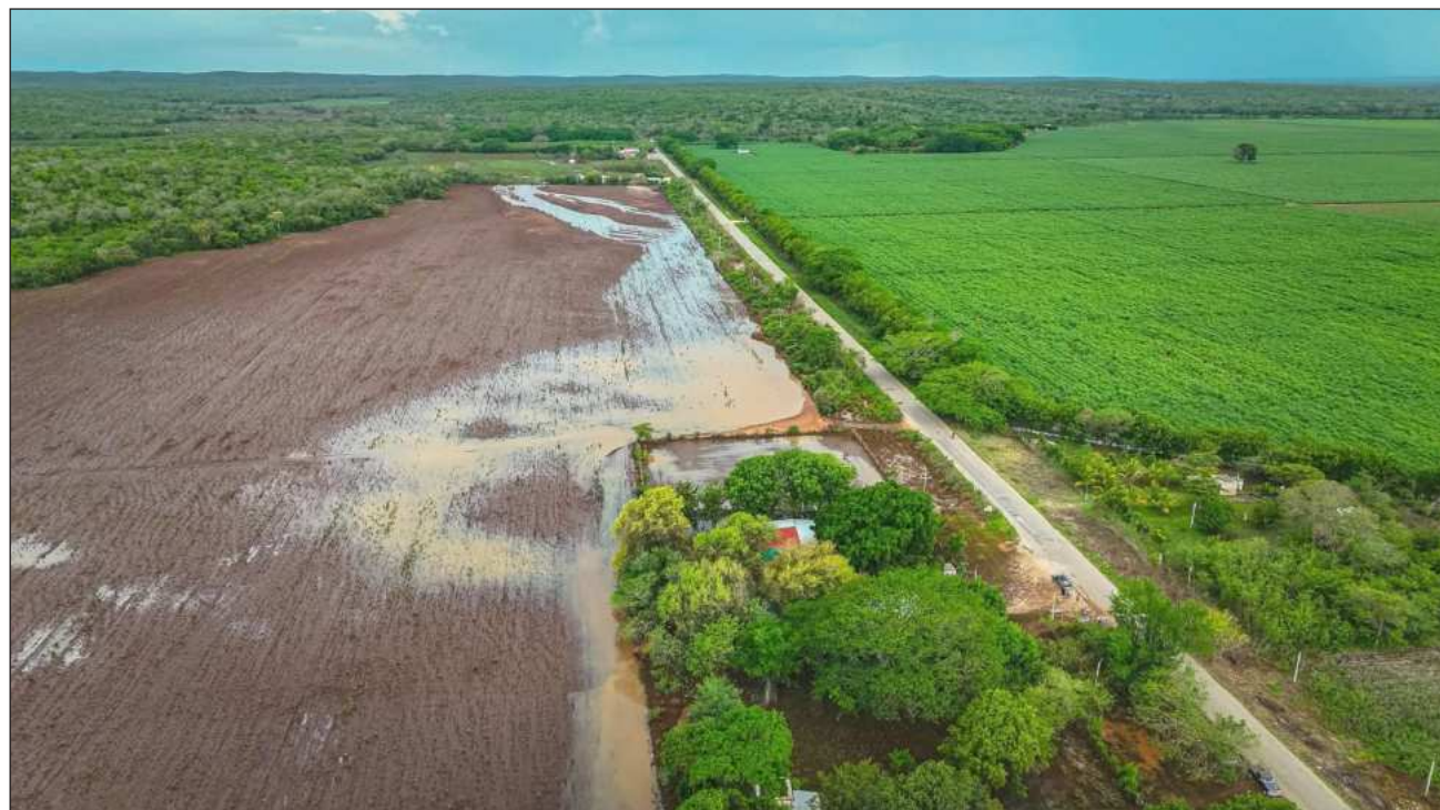
▲ Actualmente la dependencia realiza varias obras en municipios como Palizada, Carmen y la capital campechana. Foto Sedumop
