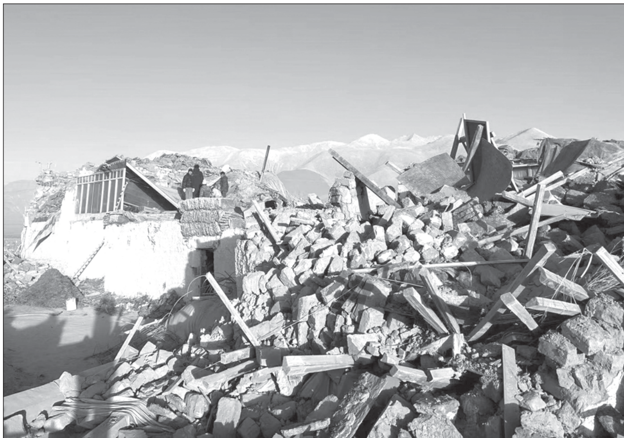
▲ El siniestro causó daños en cientos de casas, llenó las calles de escombros y dejó 188 heridos. Foto Ap
