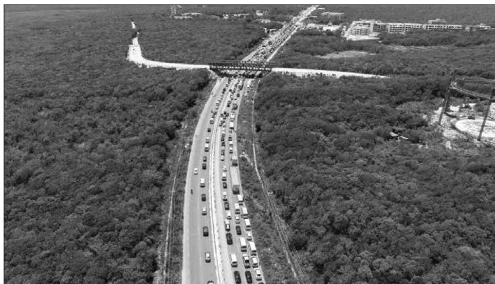
▲ El funcionario añadió que la obra contempla la construcción de tres puentes y una inversión cercana a los mil millones de pesos; los cambios sólo afectan la definición de los ramales. Foto ayuntamiento de Tulum
