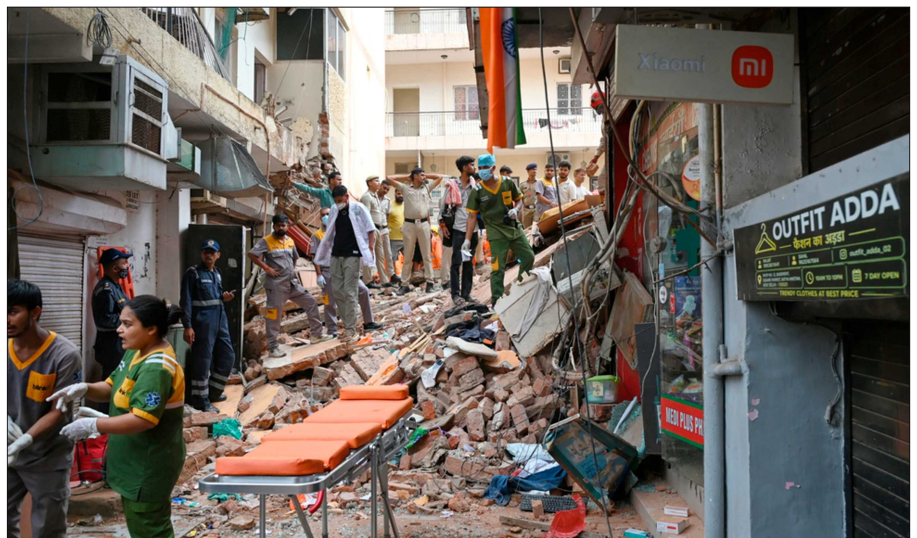
▲ Los derrumbes de edificios son un peligro recurrente en muchas partes de India durante el monzón de junio a septiembre, cuando las lluvias intensas o prolongadas pueden debilitar estructuras envejecidas. Foto Ap
