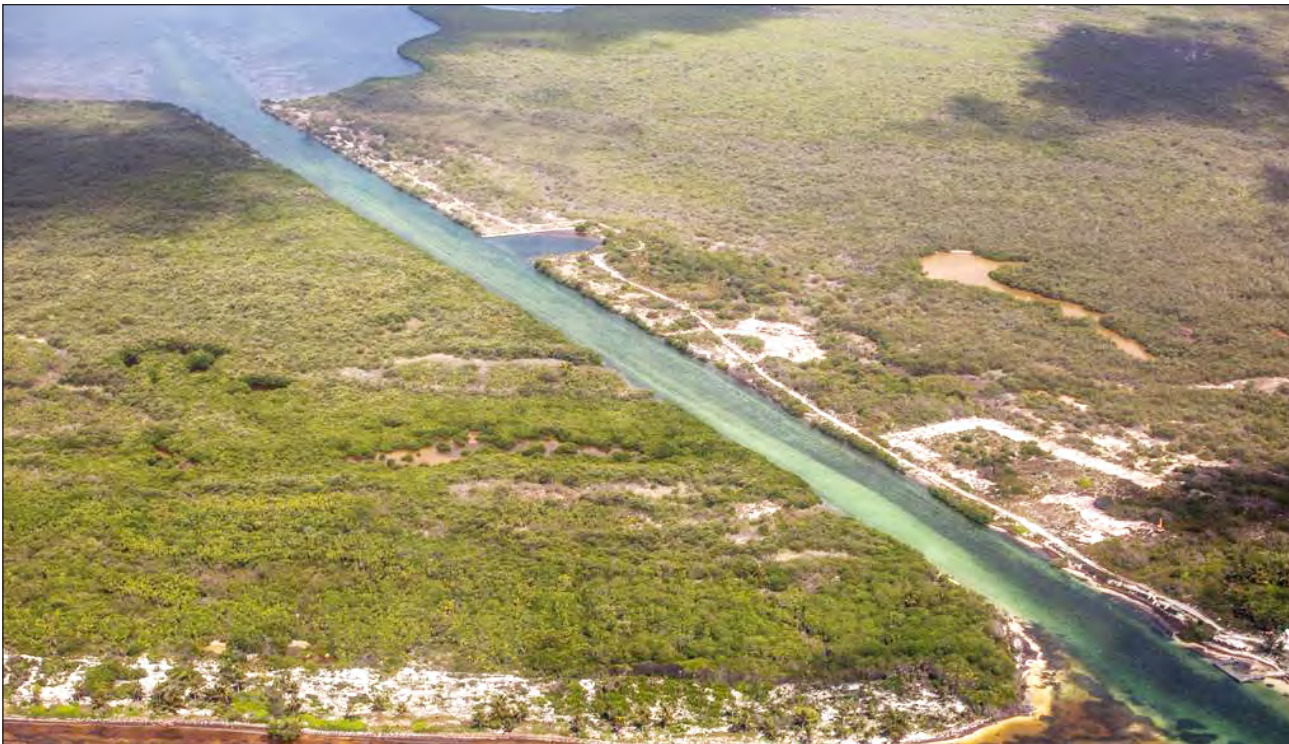
▲ Desde el inicio de su construcción en noviembre pasado, apenas hay un avance de 10 por ciento en el dragado del canal. Foto Gobierno del estado
