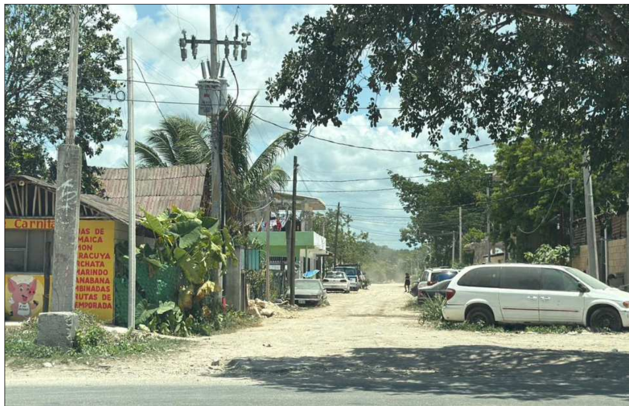
▲ De acuerdo con el integrante del Comité Étnico Pluricultural de Tulum, el proceso de electrificación inició hace algunos meses y actualmente existen comités organizados en torno a 54 transformadores distribuidos en las 14 colonias. Foto Miguel Améndola
