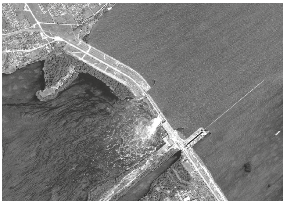
▲ El muro de una importante represa en una zona del sur de Ucrania controlada por Moscú se derrumbó el martes, provocando inundaciones y evacuaciones. Foto Reuters
