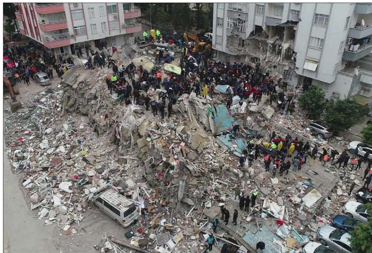
▲ Por seguridad se cortó el gas en toda la zona, debido a las réplicas y por temores a que se produjeran explosiones. Foto Reuters
