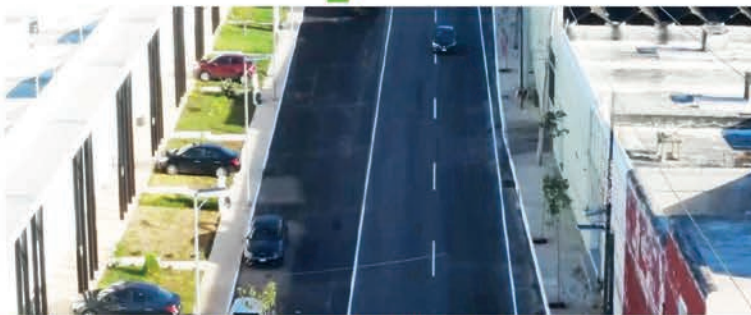
Construcción y repavimentación de más de 3.8 kilómetros de calles que abarcan la 46, 43 y 55. Adicionalmente se realizará la construcción de banquetas y guarniciones, señalética, sistema de iluminación y pozos pluviales.
