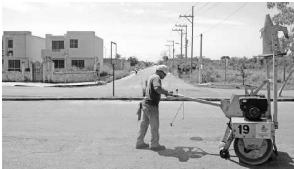
▲ Sólo en el último año de esta administración municipal se dio mantenimiento a 483 mil metros cuadrados de vialidades. Foto Rodrigo Díaz Guzmán
