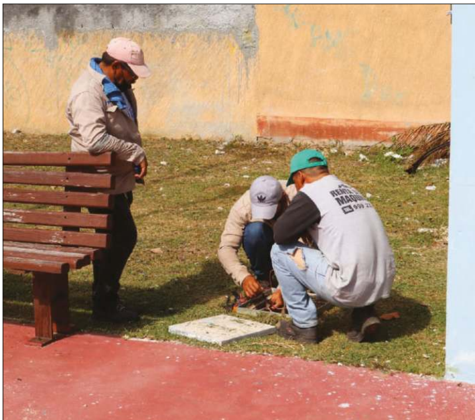
▲ Zacarías Curi externó que con estos trabajos busca que Progreso sea un municipio con lugares dignos. Foto ayuntamiento de Progreso
