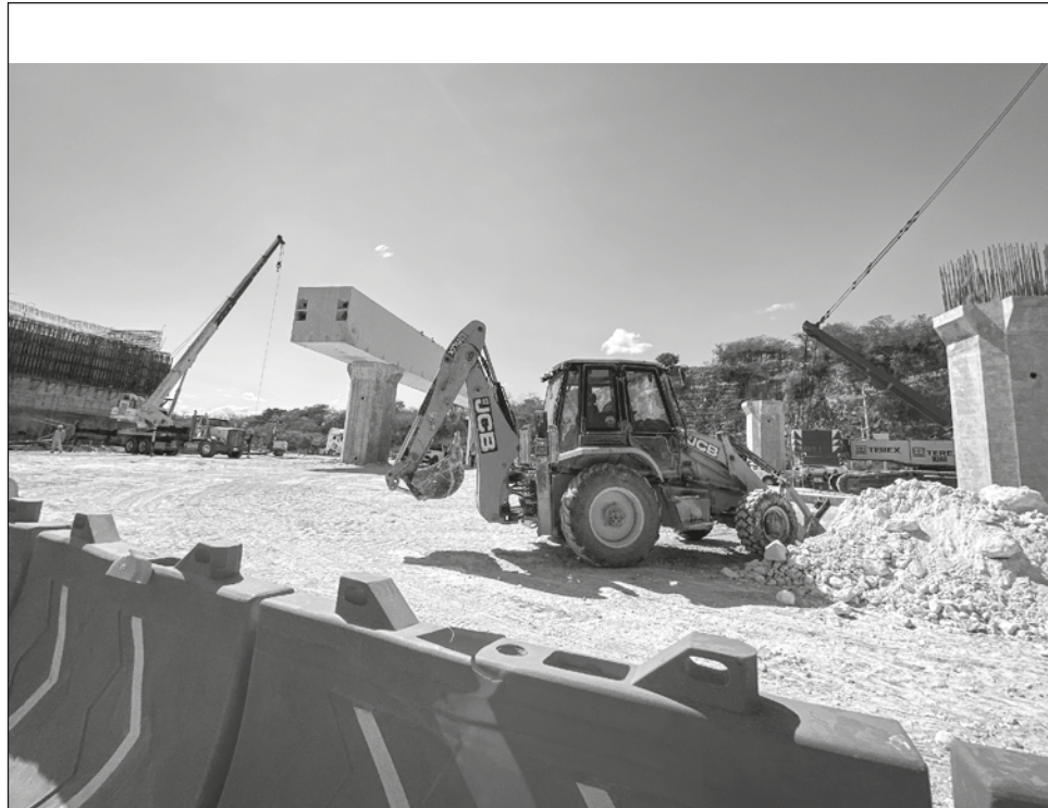
▲ En el avance general del segmento, el director general de Fonatur señaló, que se concluyeron 68 de las 69 obras de drenaje transversal y pasos inferiores. Foto Juan Manuel Valdivia
