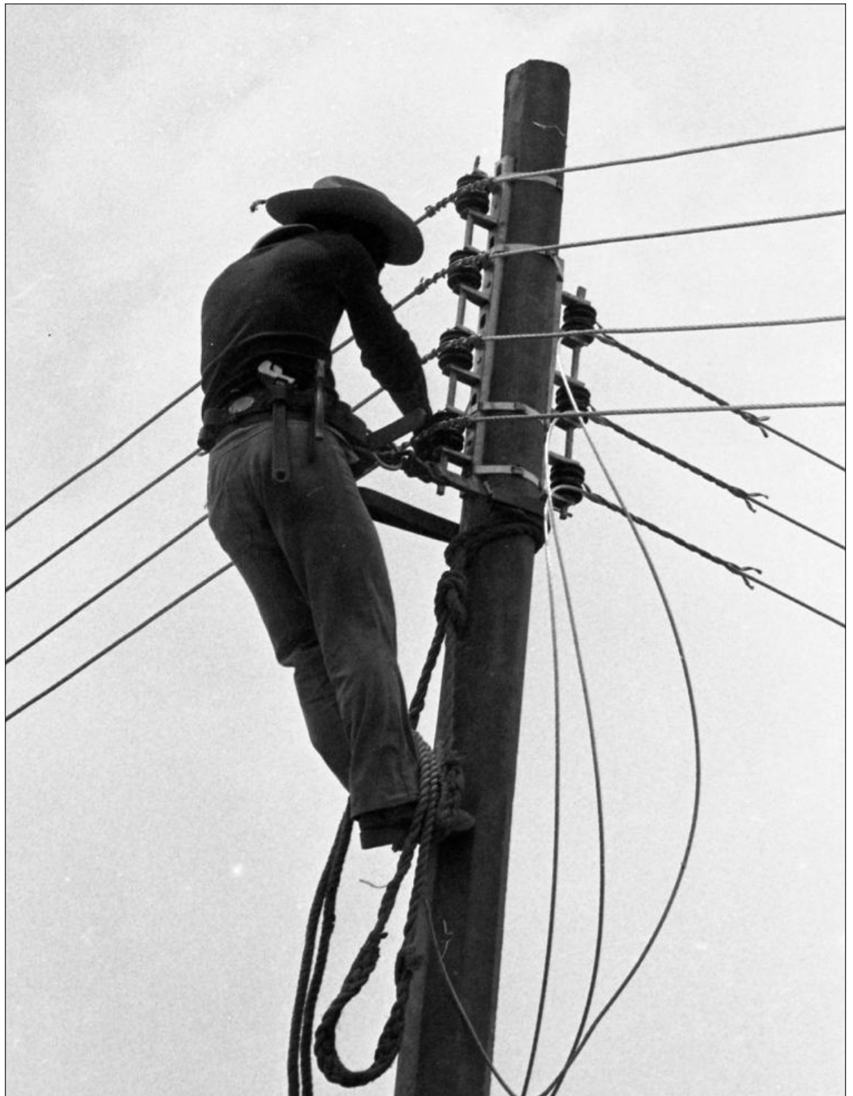
La población de Campeche, Quintana Roo y Yucatán padecen constantes cortes de energía, sobre todo en los días más calurosos que son los del mes de julio; en ese lapso los sistemas de refrigeración elevan el consumo de energía. Foto Fabrizio León
