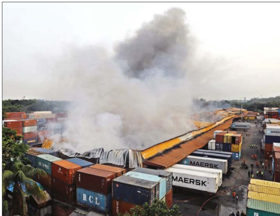
▲ El incendio fue provocado por una explosión de productos químicos en un depósito de contenedores. Estos siniestros son usuales en Bangladesh, donde se respetan poco las normas de seguridad. Foto Afp
