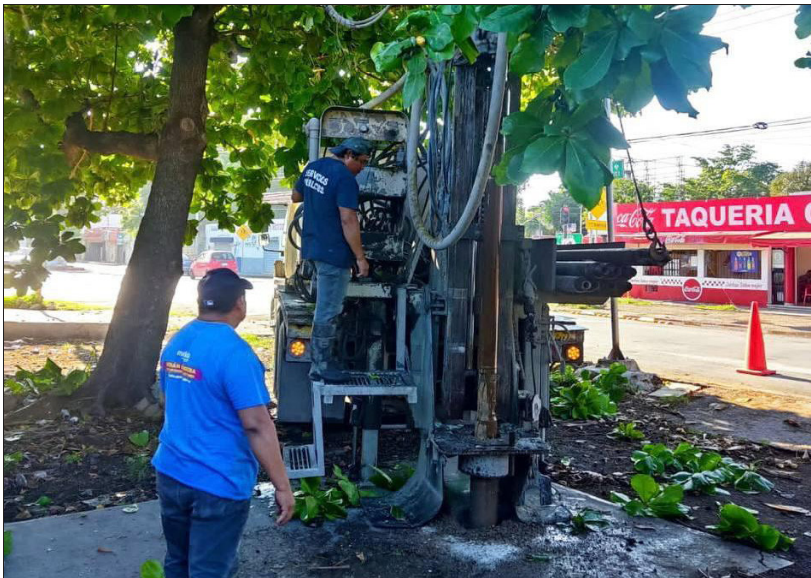
▲ La Dirección de Servicios Públicos Municipales también se mantuvo constante contacto con la Comisión Federal de Electricidad, a la que se le informó sobre el rompimiento de cables en la calle 58 entre 51 y 53 y un corto circuito generado en un poste de la calle 66 con 47. Foto ayuntamiento de Mérida
