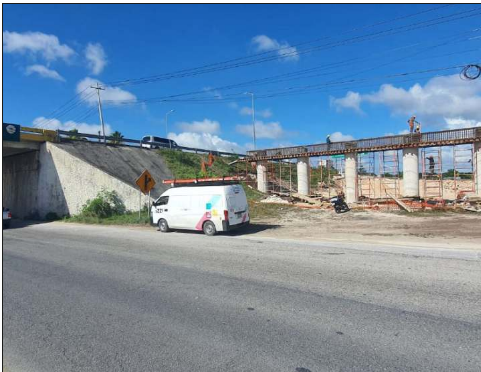
▲ Hay un avance total de 4 mil 22 metros lineales de los 13.36 kilómetros que abarca la obra, lo cual representa un progreso superior al programado: SICT. Foto Ana Ramírez
