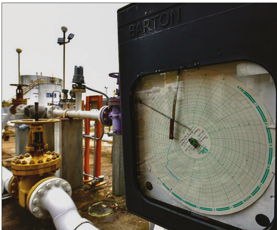
▲ Camacho espera que la investigación del accidente prometida por el Presidente reconozca la negligencia de los administradores de Pemex. Foto @Pemex
