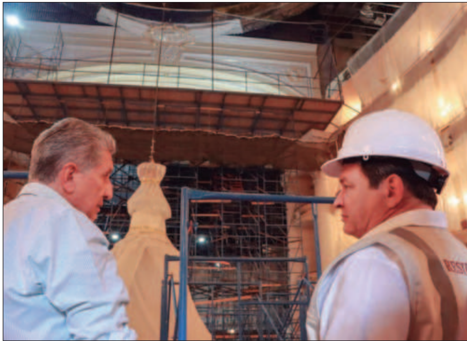
▲ Joaquín Díaz Mena realizó un recorrido de supervisión para conocer las obras de restauración que se llevan a cabo en el recinto cultural. Foto gobierno de Yucatán
