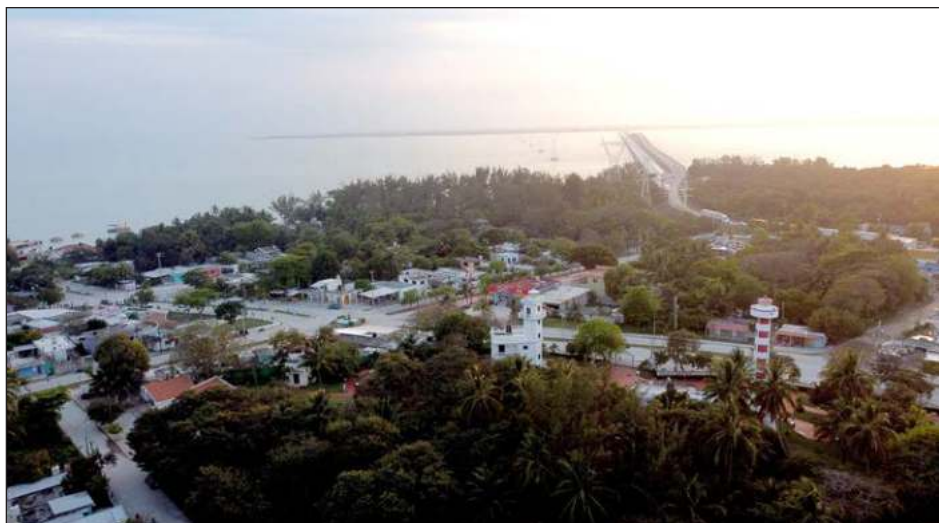
▲ Las principales avenidas del Pueblo Mágico se encuentran en malas condiciones debido a trabajos de Pemex y una intervención para introducir tuberías. Foto jusaeri
