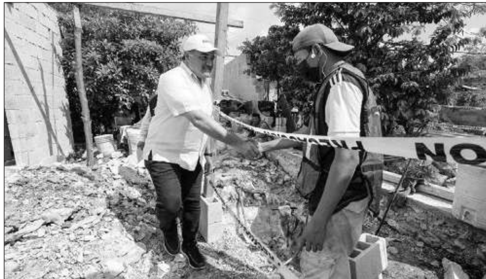
▲ El alcalde de Mérida, Renán Barrera, supervisó las acciones de vivienda que se realizan en la colonia Dzununcán, en la calle 189-1 por 80-1 y 80-A. Foto ayuntamiento de Mérida
