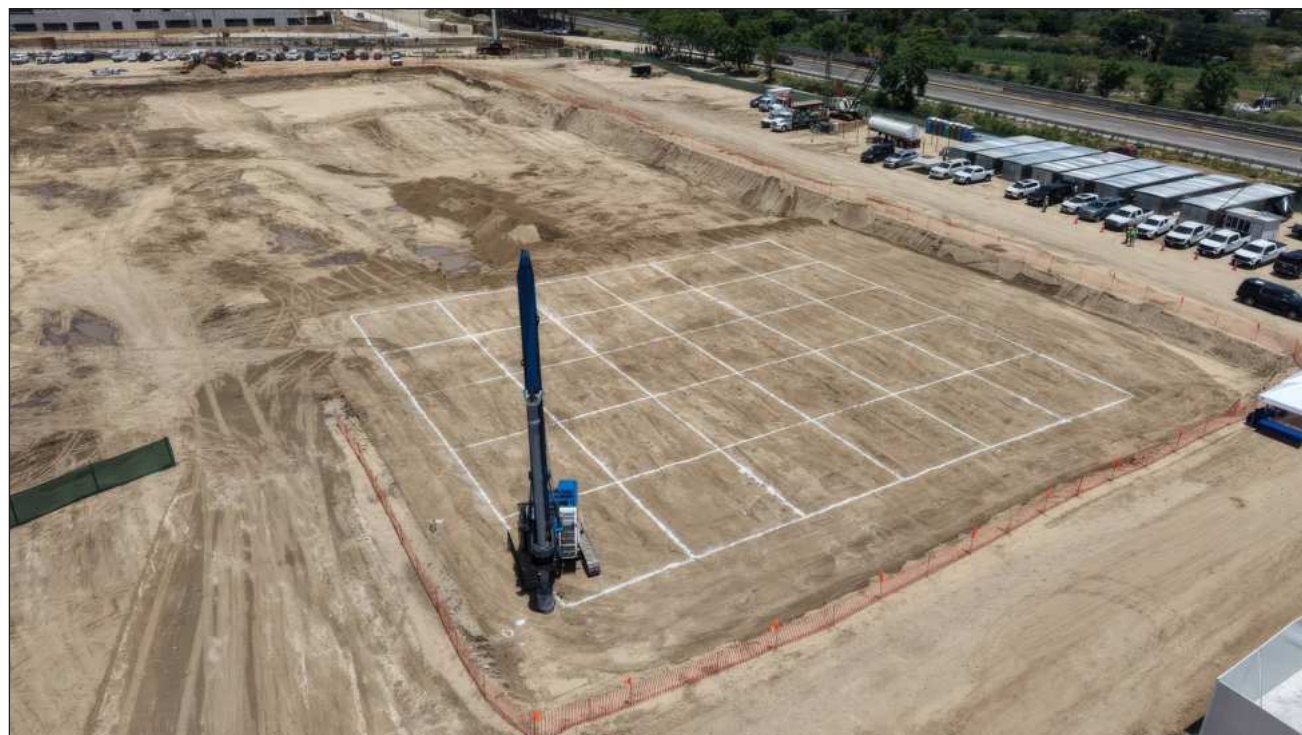
▲ En un terreno de 15 hectáreas se construye la Ciudad de la Salud “ñuu tata”, en San Lorenzo Cacaotepec, Oaxaca. Foto Presidencia
