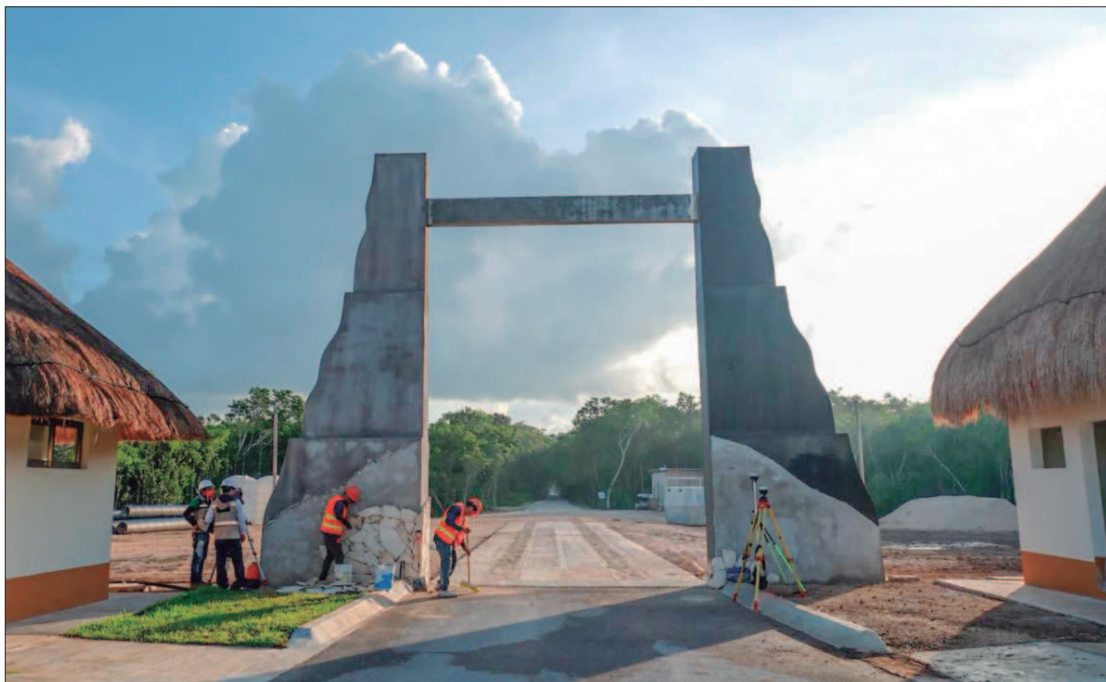
▲ "El proyecto Puerta al Mar implicó una obra que Sedena inició en 2023, incluyó un camino asfaltado de 22 y 32 km con camino tipo artesanal". Foto gobierno de Quintana Roo
