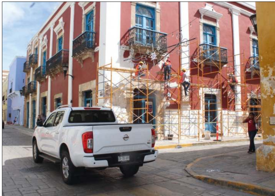
▲ El desplome de la fachada de una casona localizada sobre la calle 10 del Centro Histórico dio pie a las gestiones por recursos extraordinarios. Foto Fernando Eloy
